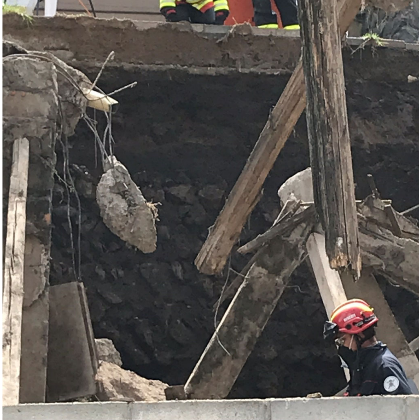
FOTOGRAFIA N 13: CONSTRUCCION DE MURO DE CONTENCIÓN DE VIA Y PROTECCION CONTRA LA HUMEDAD
