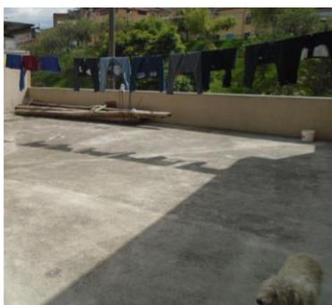
En la actualidad el inmueble se encuentra cubierto por una losa plana de hormigón armado. La suite en la segunda planta alta tiene una cubierta de asbesto cemento (Eternit).
