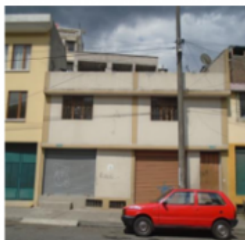
FACHADA HACIA LA CALLE ANTONIO JOSE DE SUCRE
