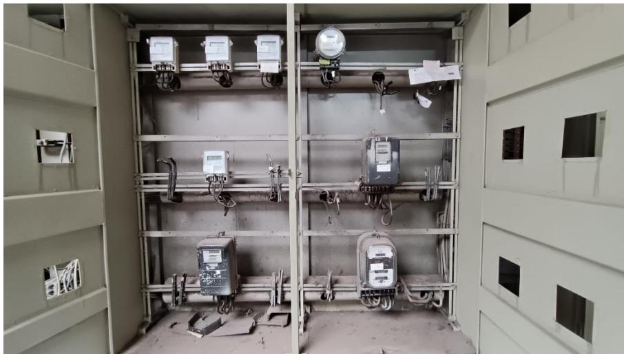
Imagen N°2: Medidores de energía
