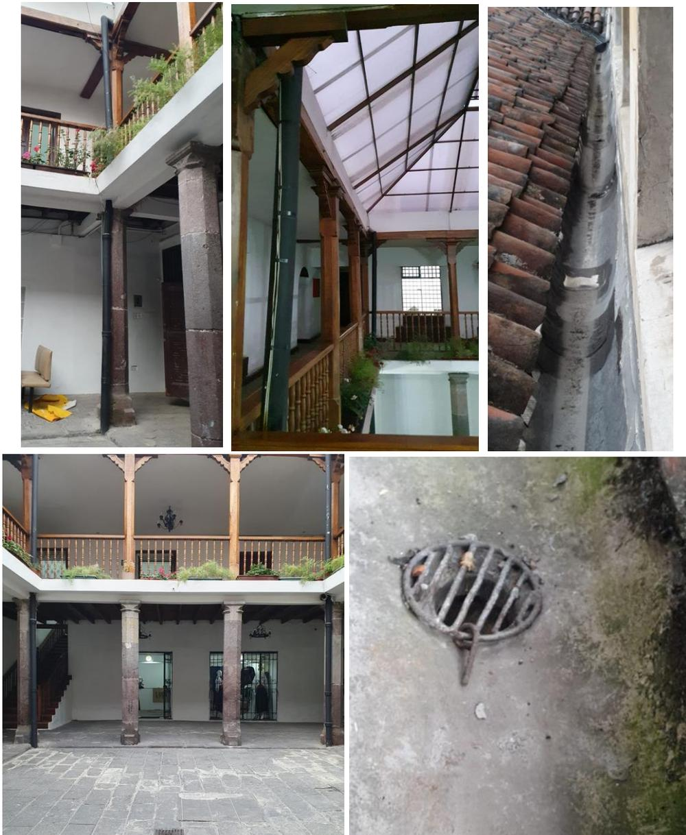
**Figura N° 10 Canales recolectores de aguas lluvias cubiertas inclinadas**
