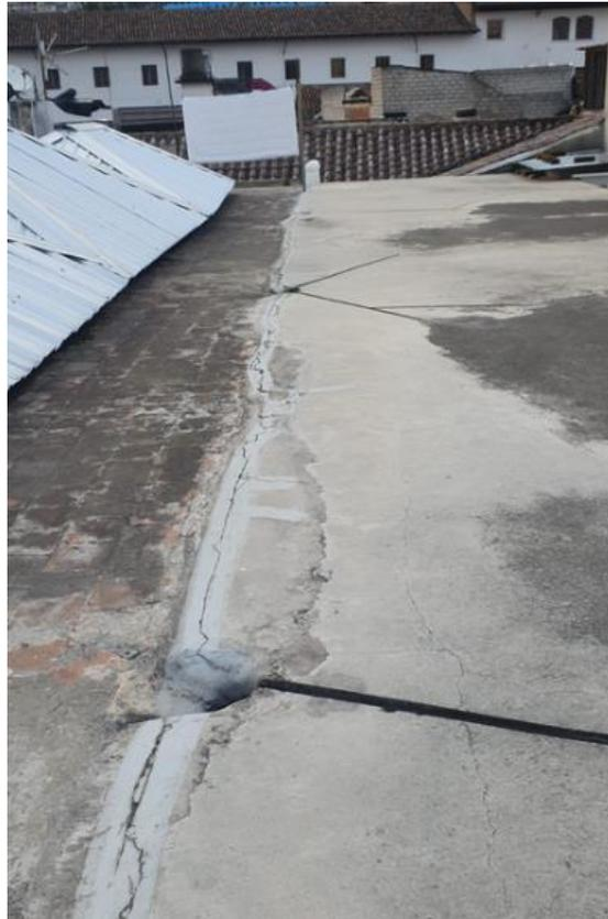
**Figura N° 11 Rejillas y desagües de piso**
