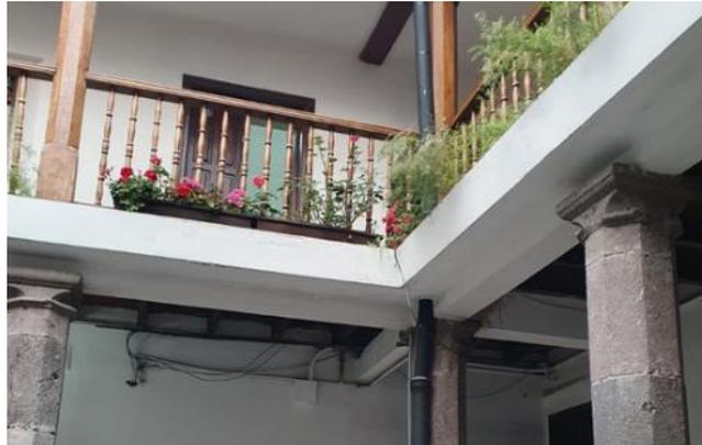
**Figura N° 12 Vigas de hormigón armado sobre columnas de piedra del patio central.**
