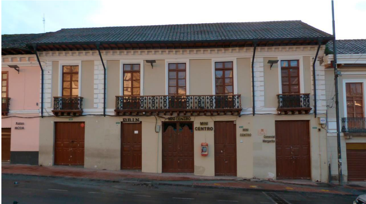
FACHADA FRONTAL DEL PREDIO N°617
