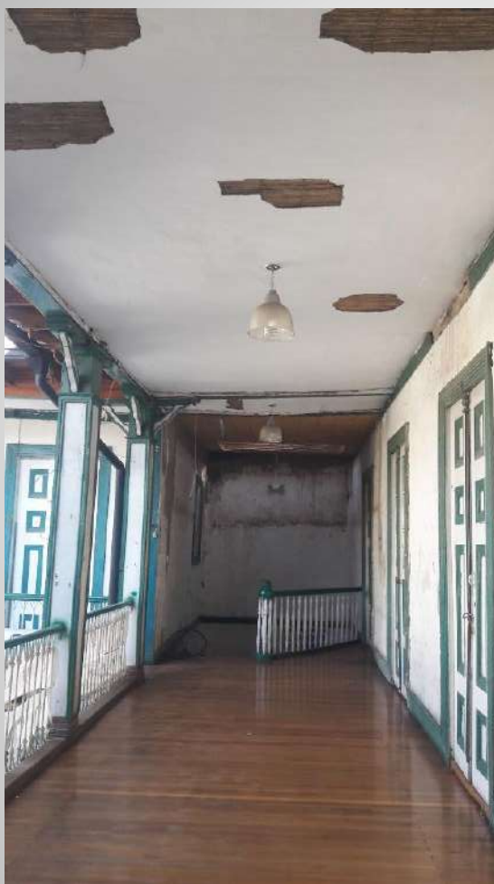
Galería A- bajo la Cubierta 1- REHABILITADA
