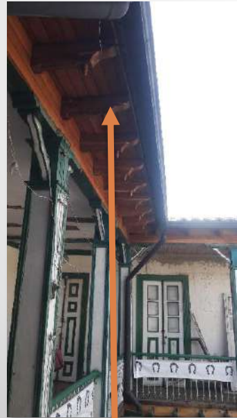
INTERVENCIÓN EN VOLADOS – CUBIERTA PATIO 1- REPOSICIÓN DE MADERA Y CANESILLOS-VIGAS
