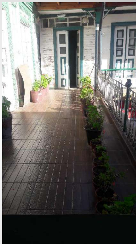
Galería D- Abierta, piso de cerámica. REHABILITADA
