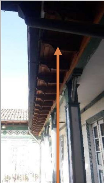
INTERVENCIÓN EN VOLADOS – CUBIERTA PATIO 1- REPOSICIÓN DE MADERA Y CANESILLOS-VIGAS
