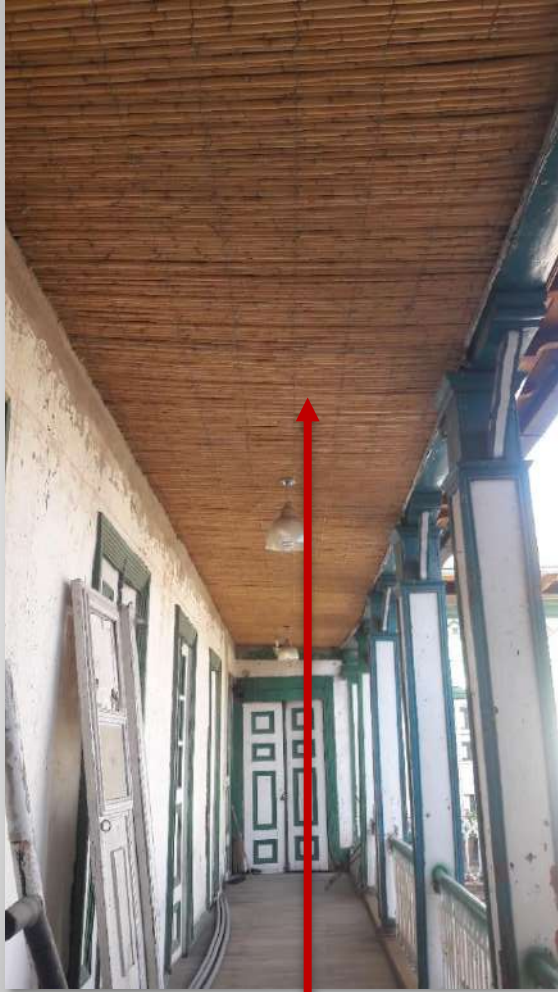
Cielo raso de carrizo en pasillo
