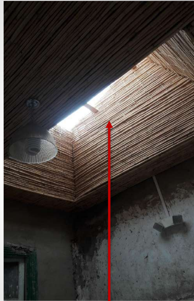
Claraboya de carrizo visto y vidrio gradas- Planta Alta.
