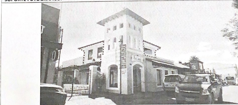
Imagen N° 1: Vista de la ampliación sobre la edificación de carácter patrimonial.
