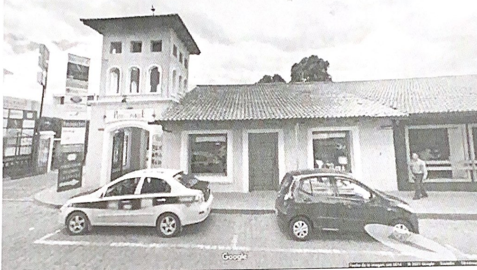
ANEXO N° 1: Vista del bien en el año 2014. FUENTE: fotografía obtenida de google maps .
