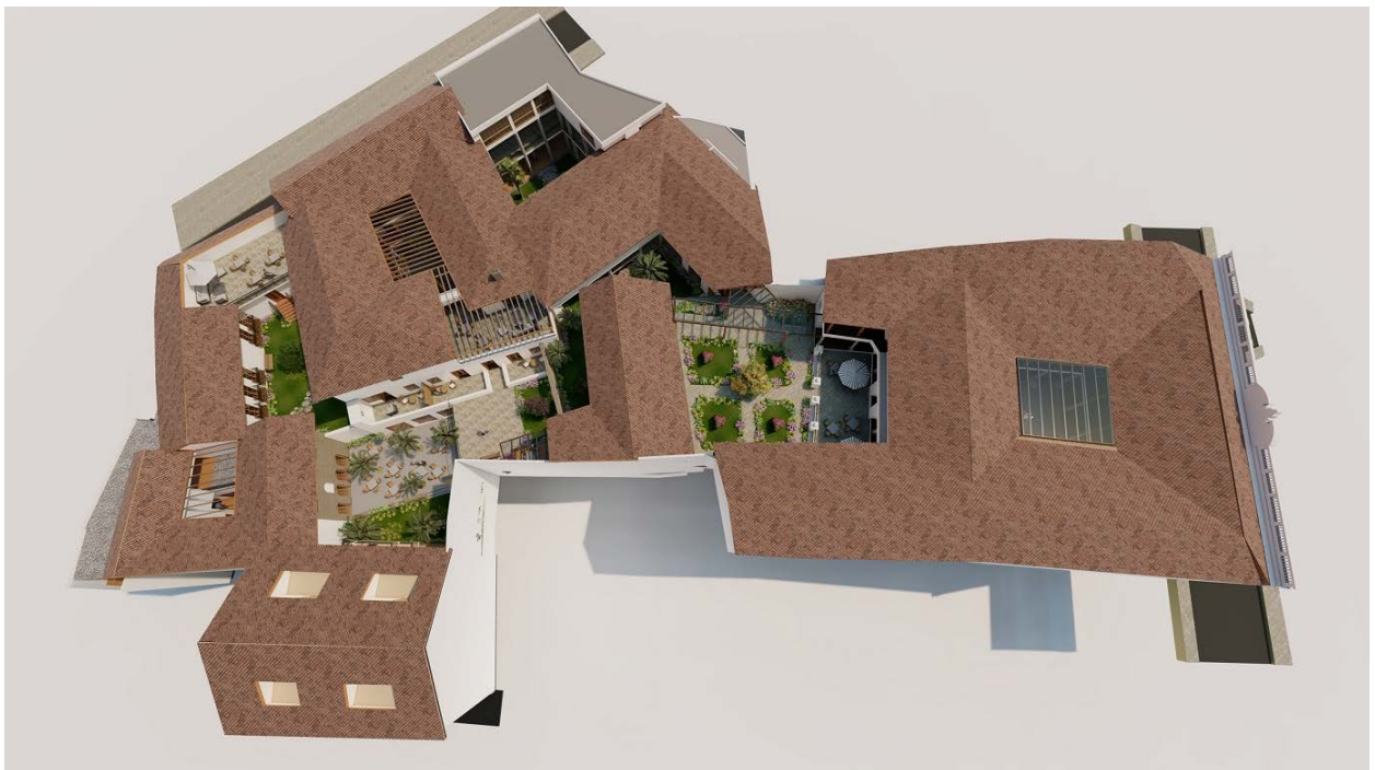
Figura 2. Distribución de techos del Hotel “La Loma”.
