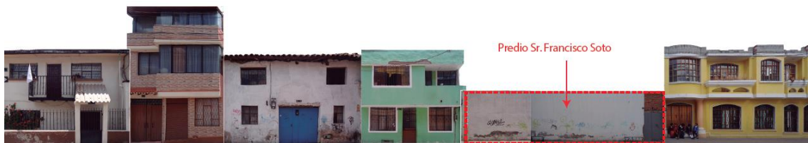
FACHADA DEL PREDIO BALDÍO Y ENTORNO (fotografía tomada de la memoria fotográfica presentada)
