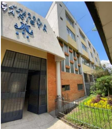
Fotografía 30: Bloque 4, vista frontal sin patologías.
