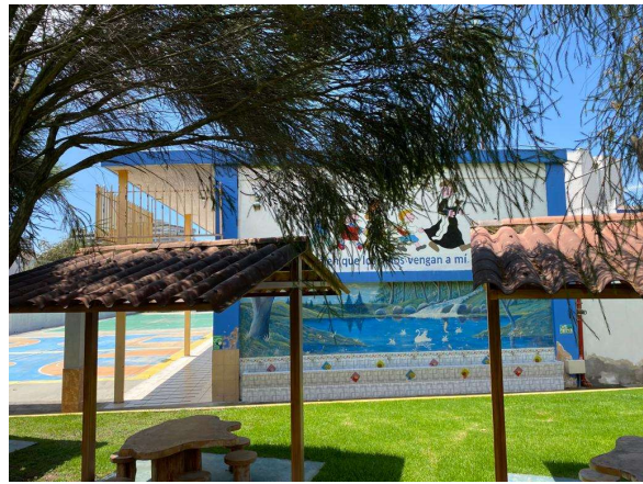
Fotografía 34: Bloque 5, 2021 fachada oeste.
