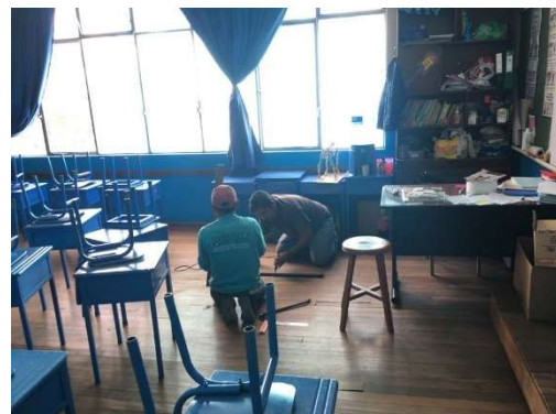
Fotografía 17: Bloque 2, Aula segundo piso. Mantenimiento de piso.
