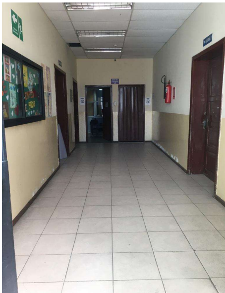
Fotografía 25: Bloque 3, 2021 pasillo interior pb.
