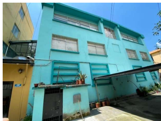
Fotografía 21: Bloque 3, 2021 Fachada posterior.
