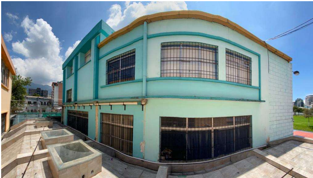
Fotografía 24: Bloque 3, 2021 Panorámica de fachada sur.
