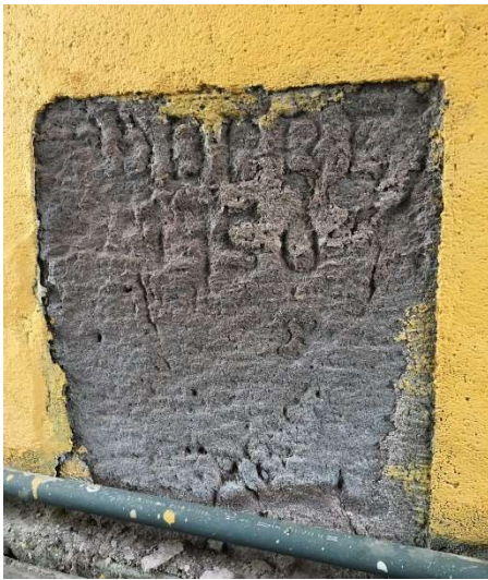
Fotografía 10: Bloque 2, 2021 Año de construcción.
