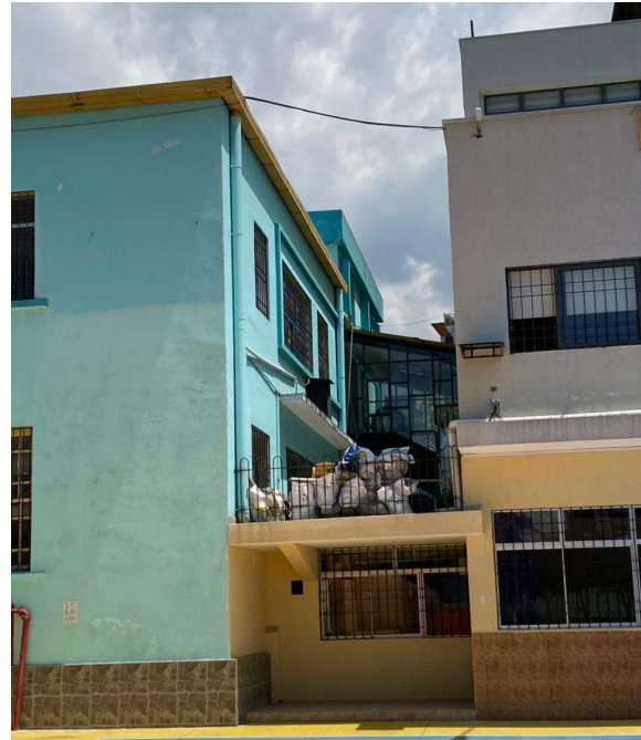
Fotografía 23: Bloque 3, 2021 Vista de fachada norte Desde el interior de las canchas.
