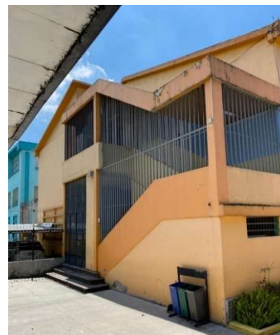
Fotografía 13: Bloque 2, Fachada posterior.
