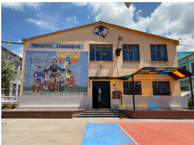
Fotografía 12: Bloque 2, 2021 fachada frontal, desde las canchas.
