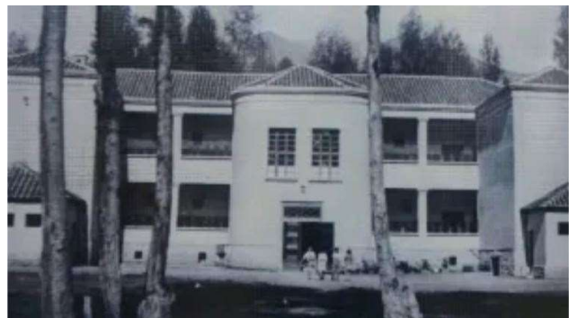
Fotografía 2: Bloque 1, 1940 fachada posterior.
