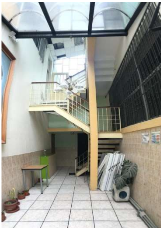
Fotografía 28: Bloque 4, Escalera de hall.
