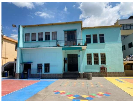
Fotografía 20: Bloque 3, 2022 Fachada frontal.
