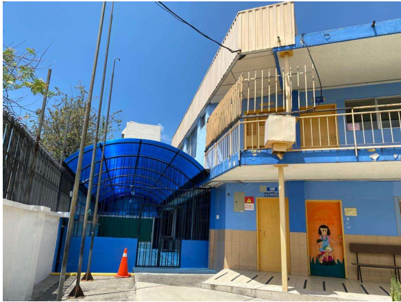
Fotografía 33: Bloque 5, 2021 esquina - vista de fachada este.
