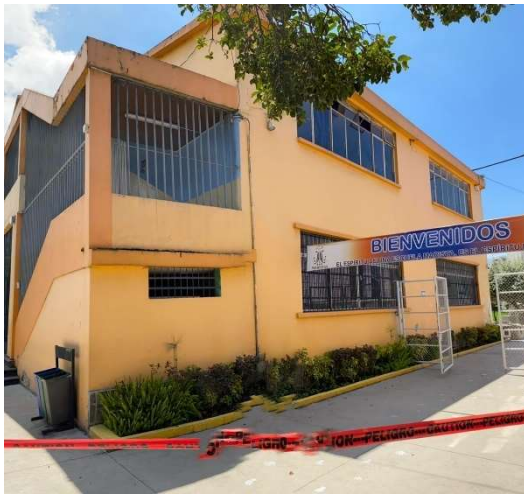
Fotografía 14: Bloque 2, 2021 Fachada sur.
