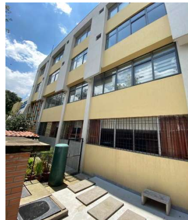
Fotografía 31: Bloque 4, vista frontal sin patologías.
