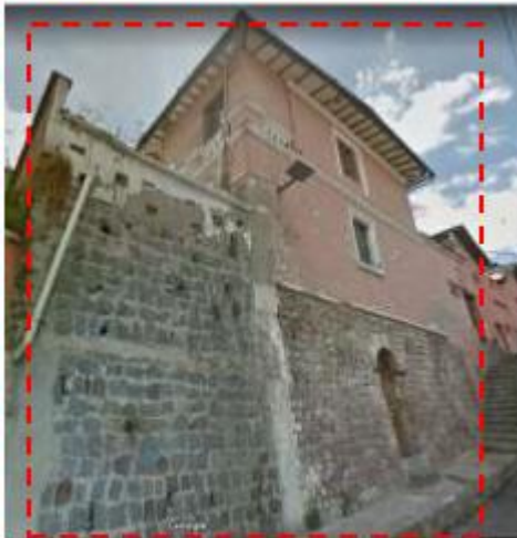
Imagen 4. Fachada sobre la calle Cuenca Fuente: Planos arquitectónicos, 2022.
