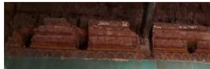
1CORNISA. Elemento arquitectónico, detalle en interior del inmueble específicamente en hall primera planta alta, confeccionado a gradiente en mampostería de ladrillo y enlucido con cal.
