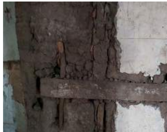
REFUERZO EN MUROS DE ADOBE CON LLAVES DE MADERA TRADICIONAL TIPO I
