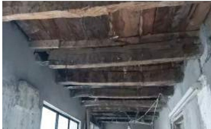
ESTRUCTURA DE MADERA TRADICIONAL A NIVEL ENTREPISO, SE COMPONE DE VIGAS DE COLORADO CON TABLA DE EUCALIPTO.
