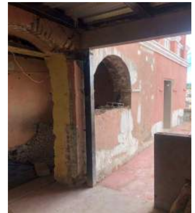
ARCOS DE MEDIO PUNTO DE LADRILLO
