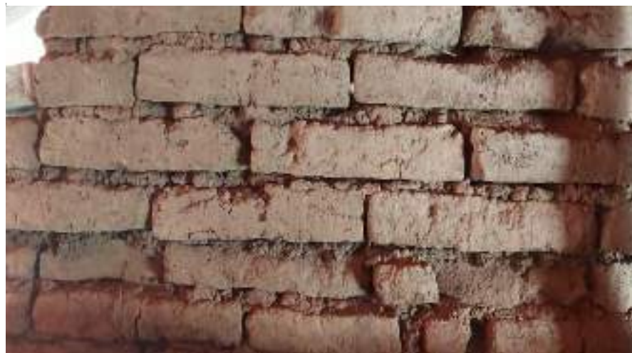
MAMPOSTERIA DE ADOBE CON MORTERO DE BARRO, MUROS DE LA EDIFICACION.
