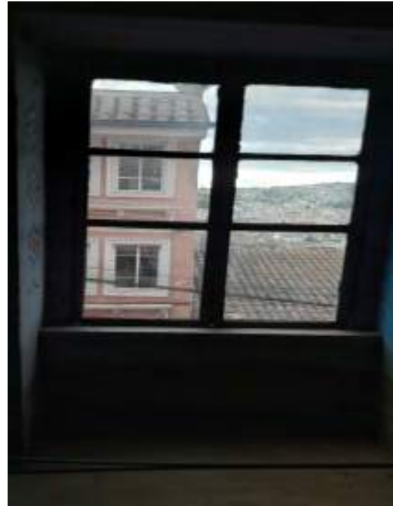
VENTANA DE MADERA DE FACHADA PRINCIPAL, CON VANO O REHUNDIDO DE MATERIALIDAD DE INICIO DE CONSTRUCCION DEL INMUEBLE
