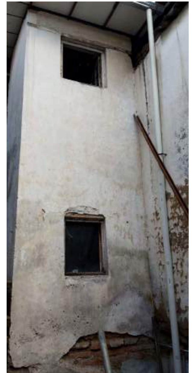
FACHADA INTERIOR QUE LINDA CON PATIO INTERIOR LATERAL IZQUIERDO, ARQUITECTURA LINEAL SIN RESALTES COLOR BLANCO, VENTANERIA TRADICIONAL, MAMPOSTERIA DE LADRILLO ENLUCIDO DE CAL CEMENTO Y BARRO.
