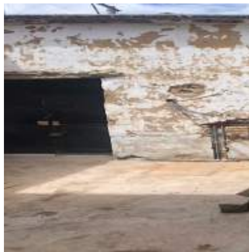
2PATIO LATERAL, Ingreso al inmueble y sirve de iluminación y ventilación de las áreas de vivienda.
