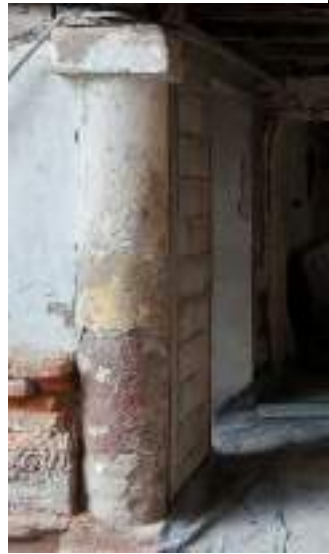
COLUMNA DORICA DE FUSTE LISO, CONFORMADA POR UN BASAMENTO Y UN ABACO, SOBRE LA CUAL SE POSICIONA EL ARQUITRABE DE MADERA
