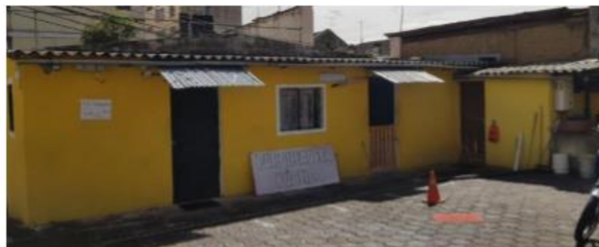
VISTA DEL INTERIOR DEL PREDIO-CONSTRUCCIÓN EXISTENTE (Tomado de la memoria histórica presentada)
