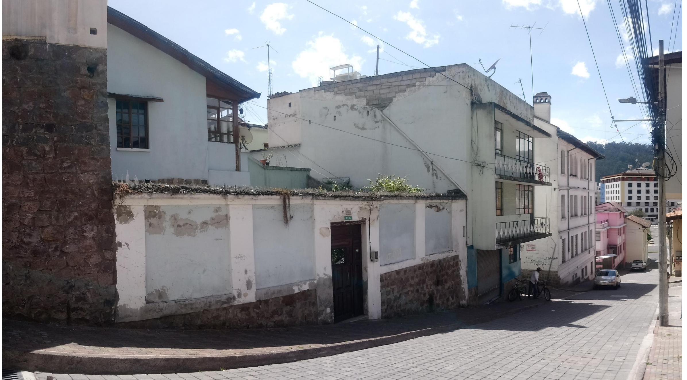
Edificaciones de la segunda cuadra subiendo por la calle Benigno Vela, lado Norte
