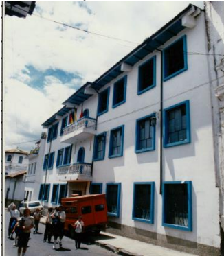
Imagen 13. Fachada principal. Fuente: Ficha Inventario DMQ, 1990
