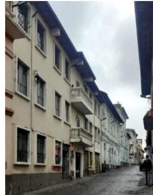
Imagen 14. Fachada principal. Fuente: Memoria Técnica, 2021.
