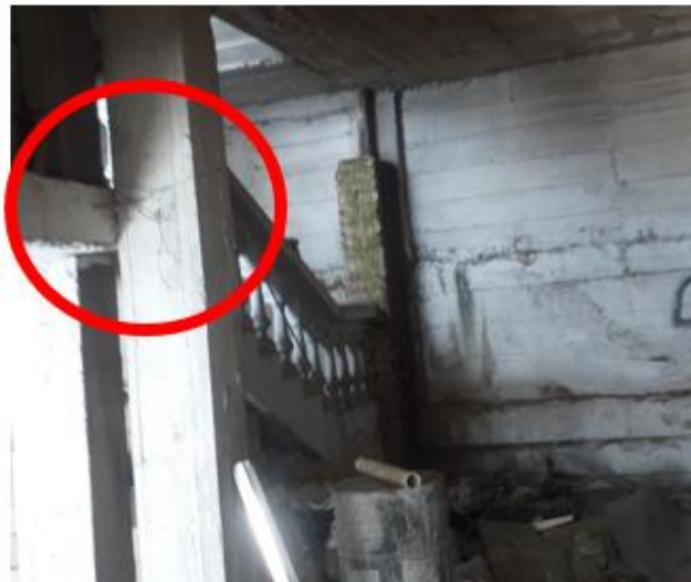
Fotografía 5. Columna corta eje D8.
