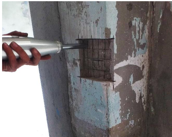
Fotografía 1. Ensayo de esclerómetro en columnas.
