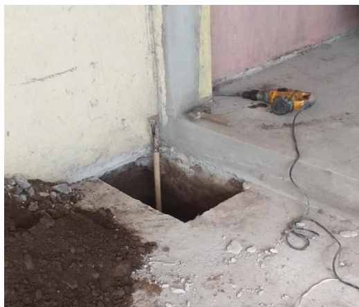
Fotografía 4. Calicata en el eje A8.
