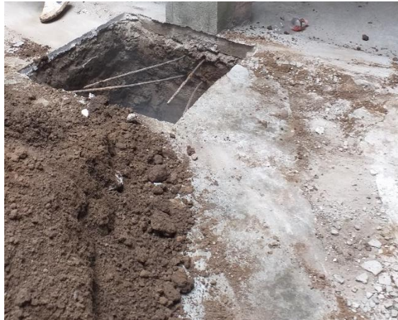
Fotografía 3. Calicata en eje 7B.
