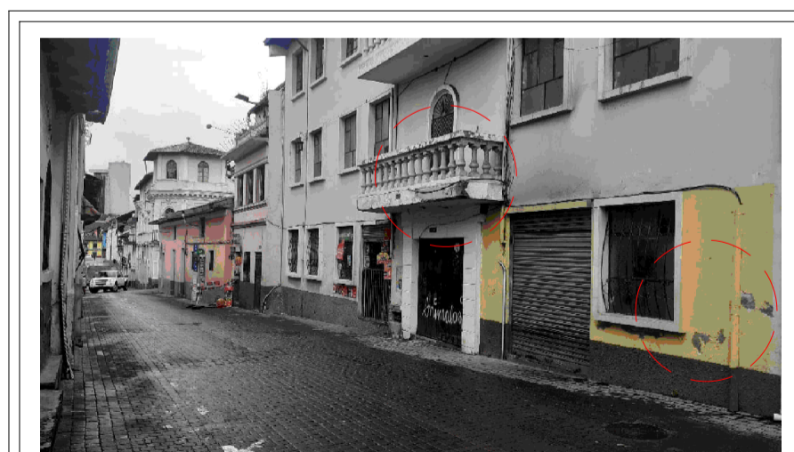
01 Desprendimiento de pintura
