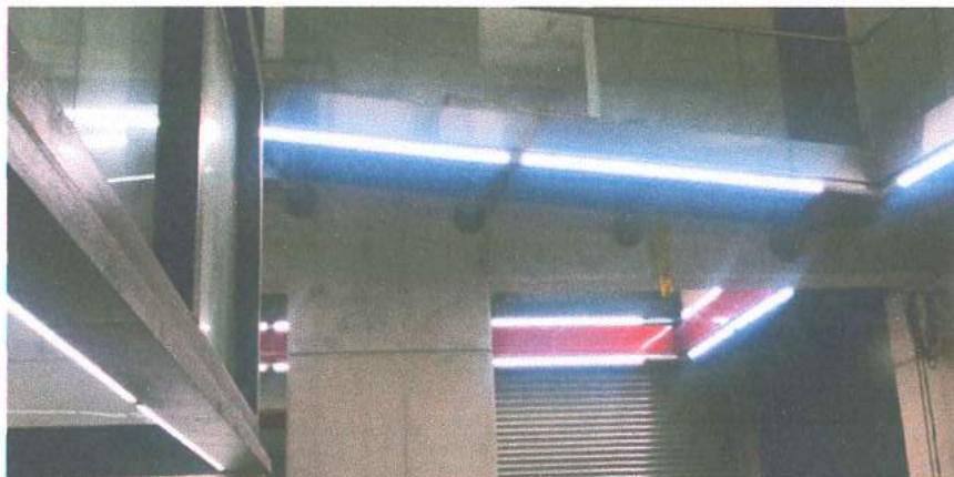
Figura.1: Instalación luminarias Canaled
