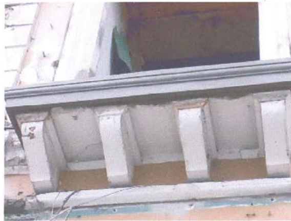
Ilustración 18 Restauración de cornisas
