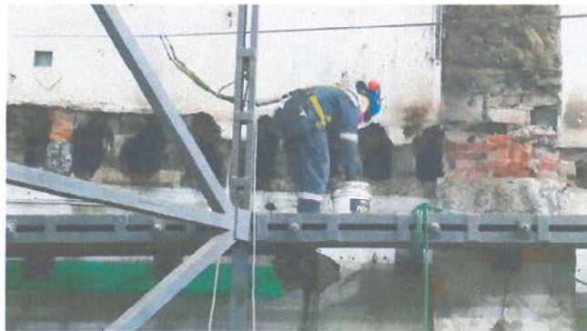
Ilustración 3 Muro sur, perforaciones por vigas de entrepiso
