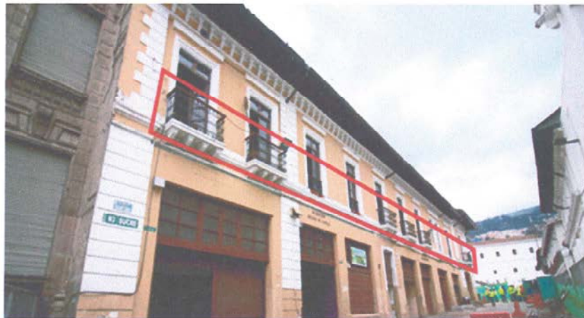
Ilustración 23 Fachada calle Sucre 2016 (balconería)
