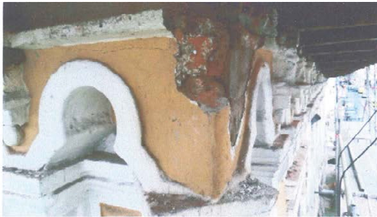
Ilustración 19 Cornisamentos y ménsulas
