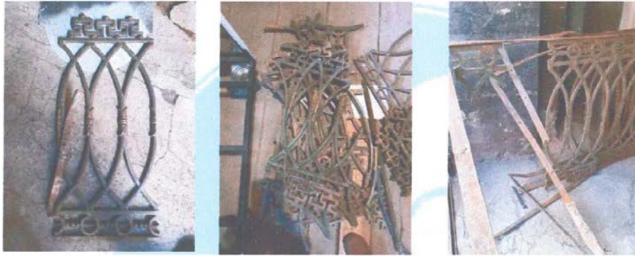
Ilustración 28 Restauración pasamanos de hierro fundido
