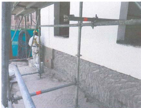
Ilustración 21 Reposición de piedra en zócalo calle Sucre
