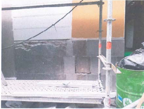
Ilustración 22 Reposición de piedra en zócalo
