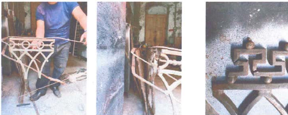
Ilustración 26 Restauración de pasamanos metálicos (hierro fundido)
