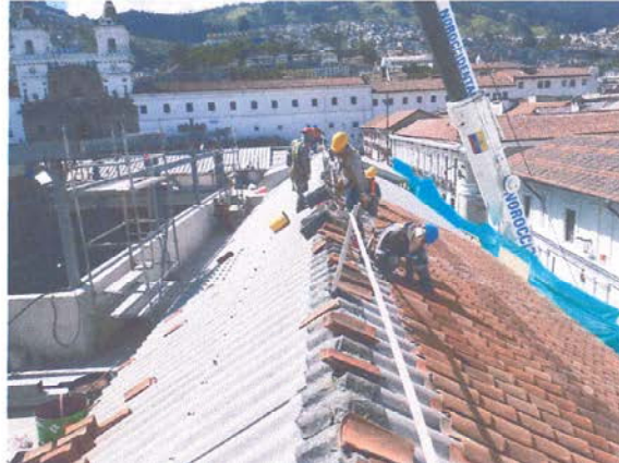
Ilustración 10 Entejado sobre placa de fibrocemento
