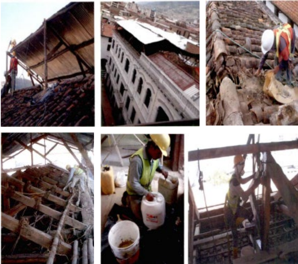
Figura 18: Intervención en la cubierta. Fuente: Villegas 2016a.
