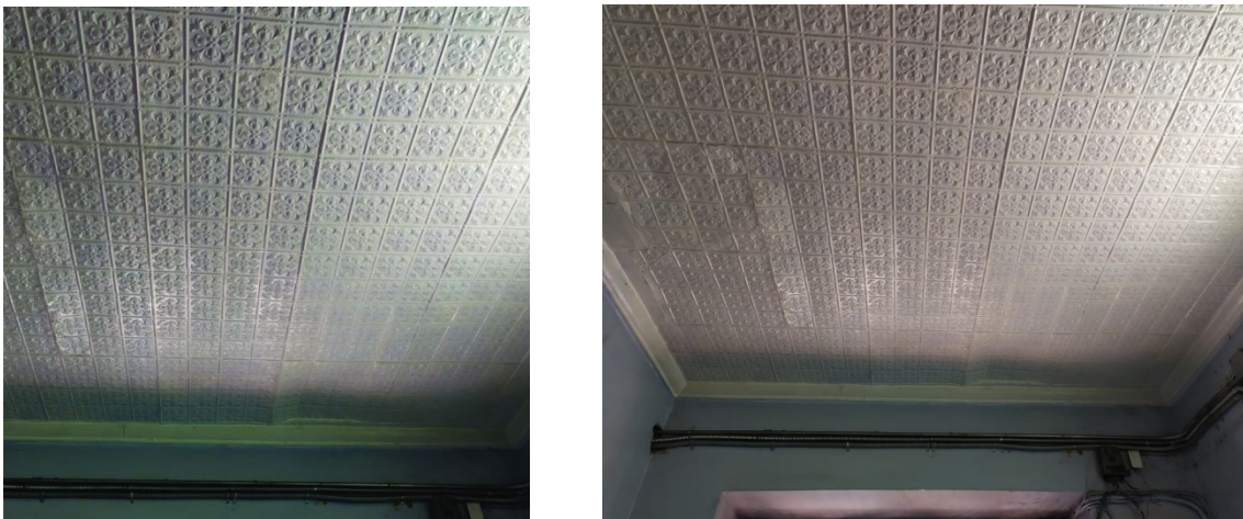
Figura 36: Referencia del tipo de latón y estado de conservación.
