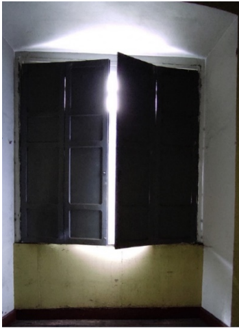
Figura 37: Ventanas y contraventanas interior.
