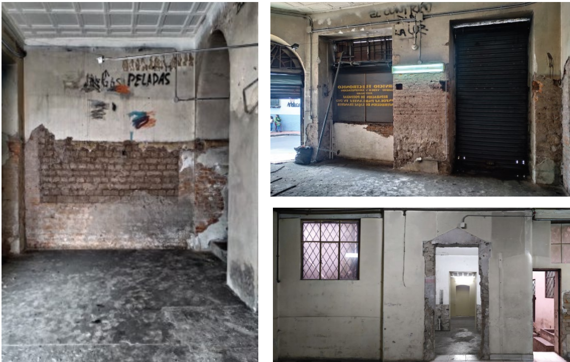
Figura 30: Algunos materiales visibles: muros portantes y pavimentos.
