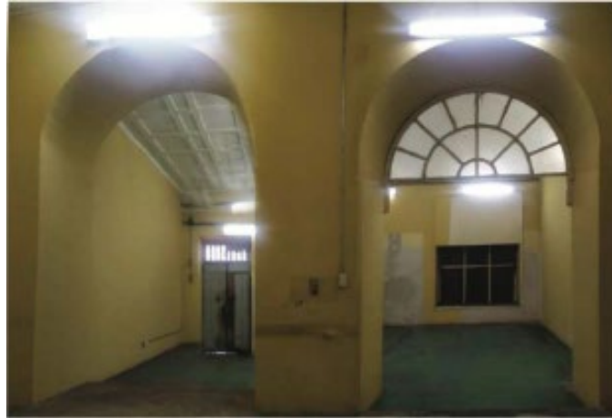
Figura 40: Arquerías de madera en muros interiores.
