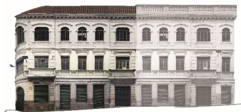
Figura 34: Edificio historicista completo hacia la calle Vargas.
