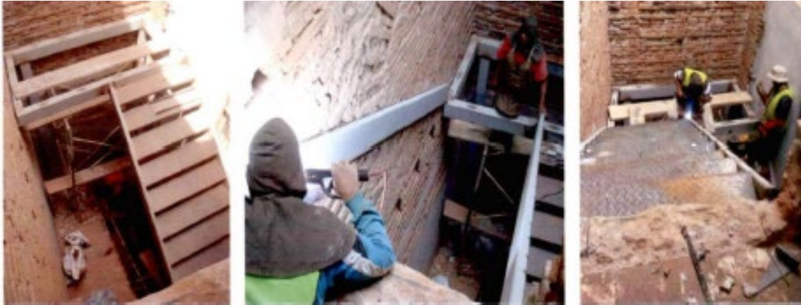
Figura 19: Intervención de la escalera de emergencia. Fuente: Villegas 2016a.
