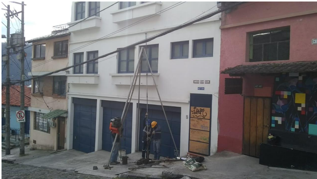
Foto 1. Pozo de perforación PP-1
