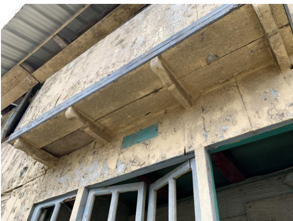
Detalle de canecillos y mampostería de madera
