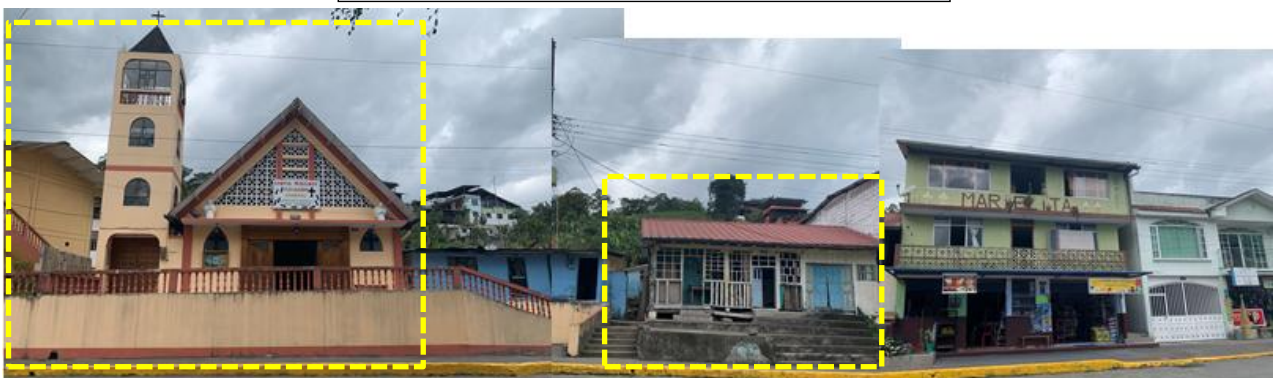
Tramo 1: Calle Kennedy entre calle El Rosal y calle Chontapambita
