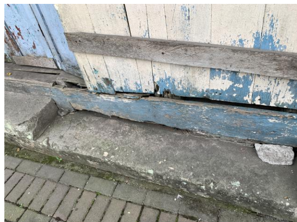
Detalle de canecillos y mampostería de madera
