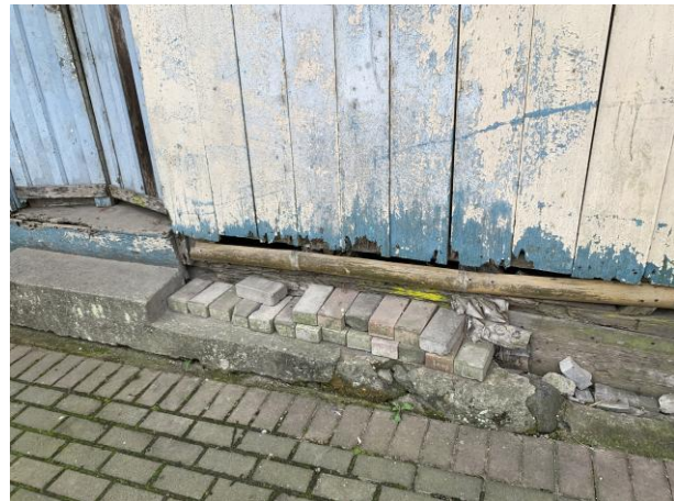
Vista de antepecho de madera y detalle de mampostería de madera en mal estado
