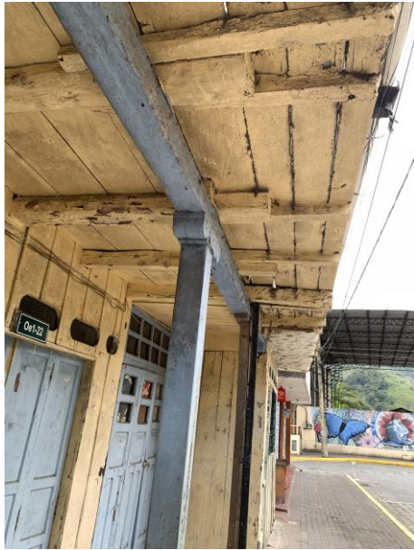
Vista de columnas y vigas -- Vista de apuntalamiento de vigas en planta baja la misma que no se encuentra habitada.
