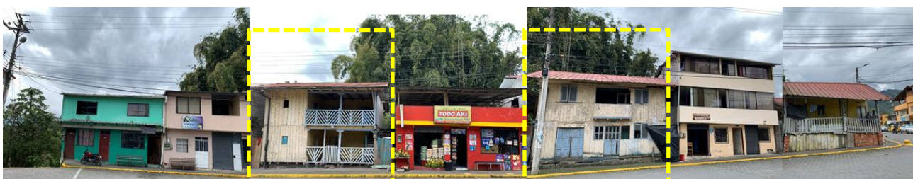
Tramo 4: Calle el Rosal entre calle Kennedy y calle Cumandá
