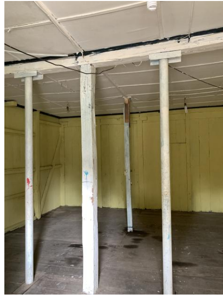
Vista de columnas y vigas -- Vista de apuntalamiento de vigas en planta baja la misma que no se encuentra habitada.
