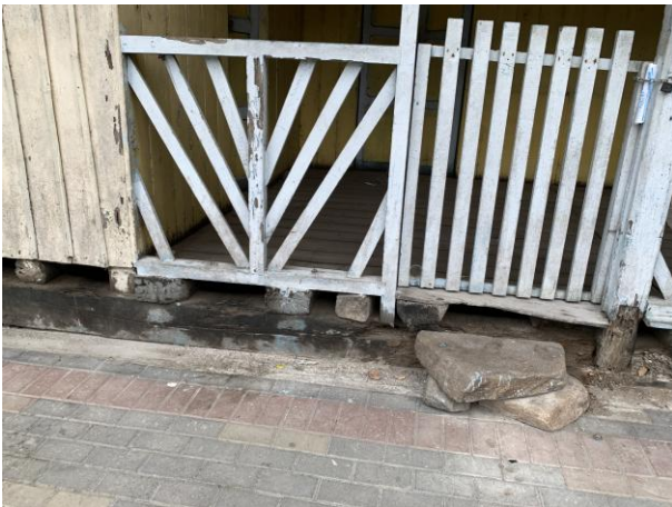
Vista de antepecho de madera y detalle de mampostería de madera en mal estado
