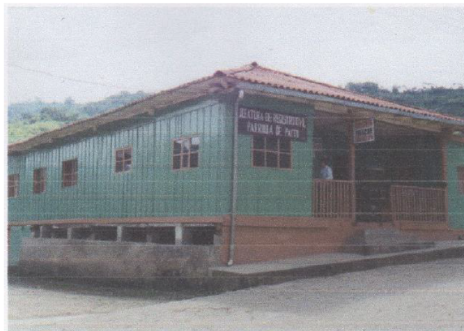
Imagen 4. Edificación antes del incendio. Fuente: Ficha de inventario, 1998.
