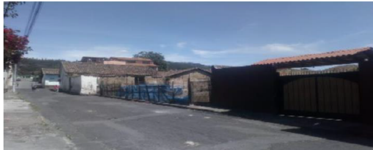
FACHADA FRONTAL DEL PREDIO
