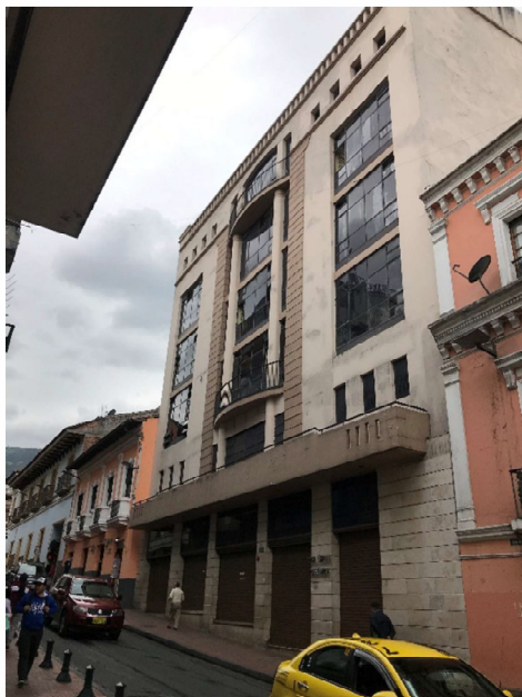
IMG03. EDIFICIO COAC DAQUILEMA – FACHADA ESTADO ACTUAL
