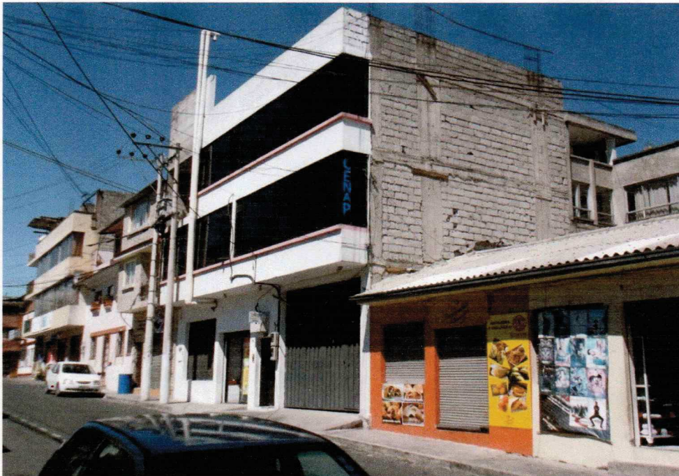
CALLE JOSÉ JOAQUÍN OLMEDO (F-10): ENCONTRAMOS CONSTRUCCIÓN DE ESTRUCTURA DE H-A, PAREDES DE LADRILLO Y BLOQUE, DESARROLLADA EN DOS Y TRES PLANTAS, CUBIERTA DE LOSA PLANA.
