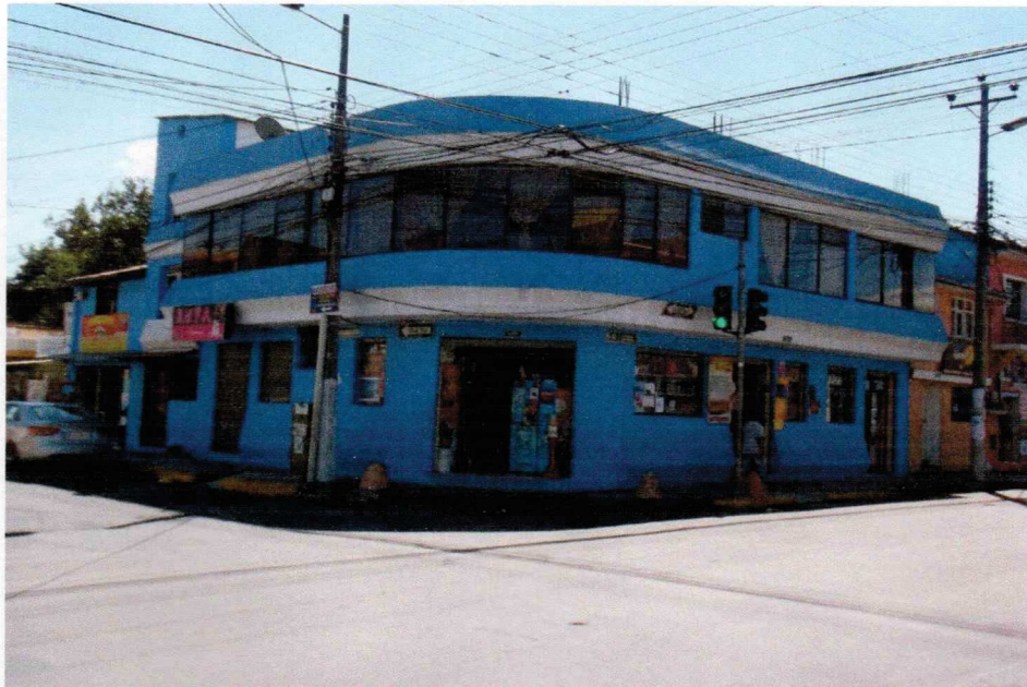
INTERSECCION CALLE JOSÉ JOAQUÍN DE OLMEDO Y SIMÓN BOLÍVAR (F-7), ENCONTRAMOS UNA CONSTRUCCIÓN DE ESTRUCTURA DE H-A, PAREDES DE LADRILLO DESARROLLADA EN DOS PLANTAS, CUBIERTA DE LOSA PLANA.
