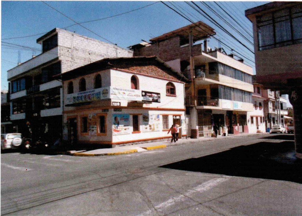
INTERSECCION CALLE JOSE JOAQUIN OLMEWDO Y LUIS PROAÑO (F-12): CONSTRUCCIÓN DE H-A CON PAREDES DE LADRILLO, CUBIERTA METÁLICA INCLINADA A DOS AGUAS
