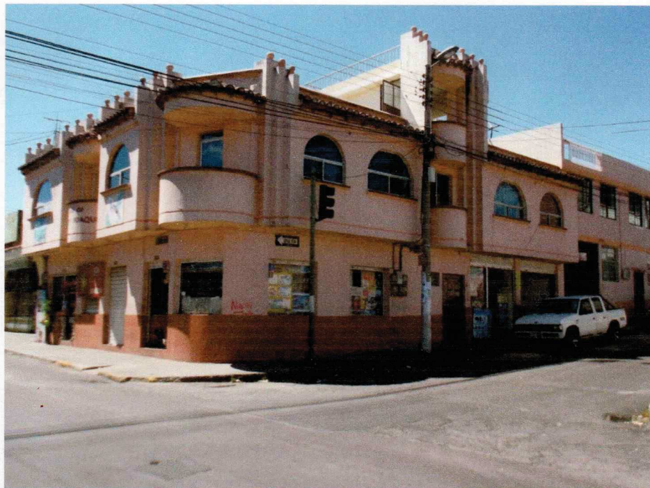
INTERSECCION CALLES SIMON BOLIVAR Y JOSE JOAQUIN OLMEDO (F-8): EN LA OTRA INTERSECCIÓN ENCONTRAMOS UNA CONSTRUCCIÓN DE ESTRUCTURA DE H-A, PAREDES DE LADRILLO DESARROLLADA EN DOS PLANTAS, CUBIERTA DE LOSA PLANA CON DETALLE EN LA PARTE FRONTAL DE CUBIERTA INCLINADA DE TEJA.
