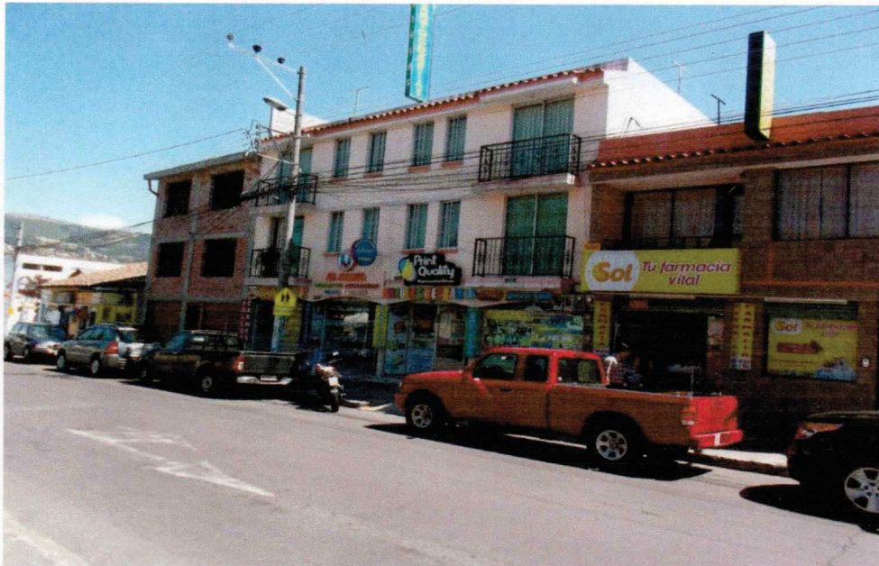
CALLE SIMÓN BOLÍVAR (F-5): EN LA PARTE FRONTAL DE ESTE PROYECTO, EN LA CALLE SIMÓN BOLÍVAR ENCONTRAMOS CONSTRUCCIONES EN H-A PAREDES DE BLOQUE Y LADRILLO DESARROLLADAS EN 2 Y TRES PISOS, CUBIERTAS DE LOSA PLANA CON DETALLE FRONTAL DE CUBIERTA INCLINADA DE TEJA.
