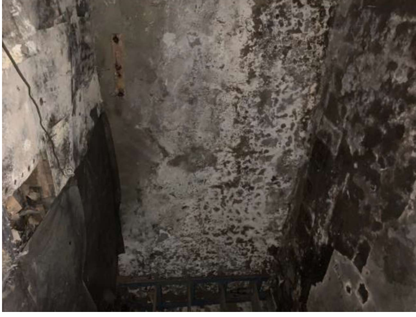
VISTA PARED PISO Y TUMBADO
