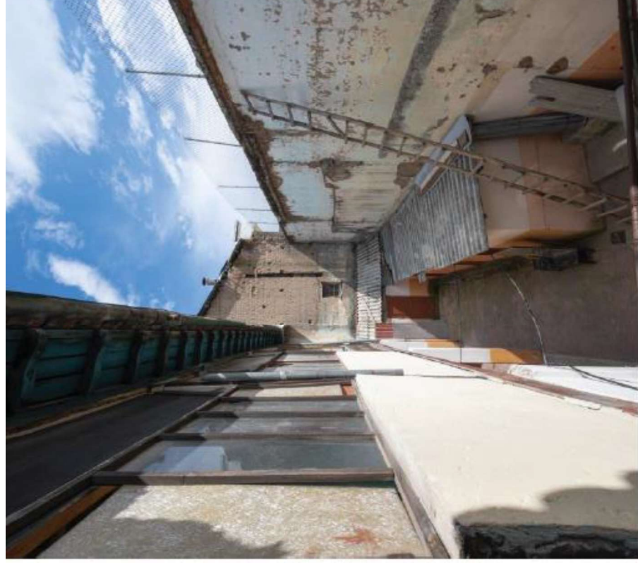
VISTA POSTERIOR DEL INMUEBLE-AÑADIDOS
