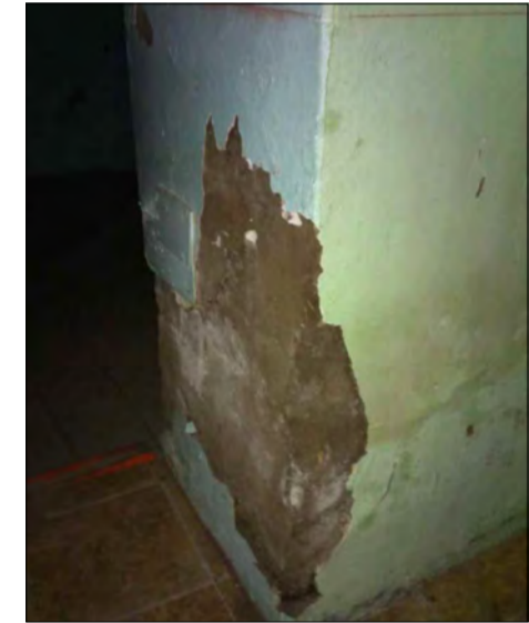
2. DESPRENDIMIENTO DE ENLUCIDO - HUMEDAD
