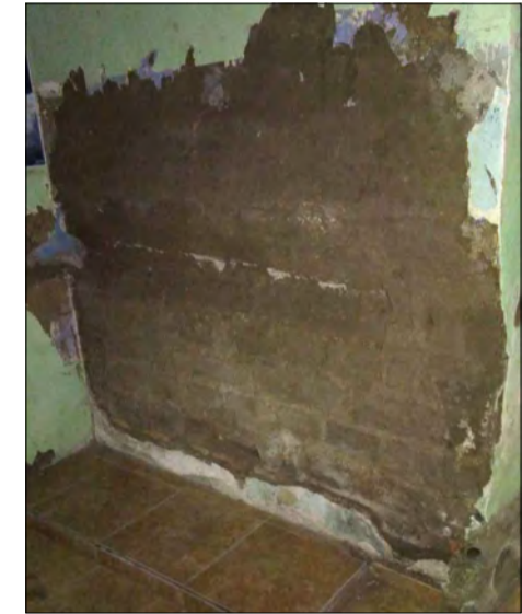
1. DESPRENDIMIENTO DE ENLUCIDO - HUMEDAD ESCASO ACCESO DE ILUMINACIÓN Y VENTILACIÓN NATURAL
