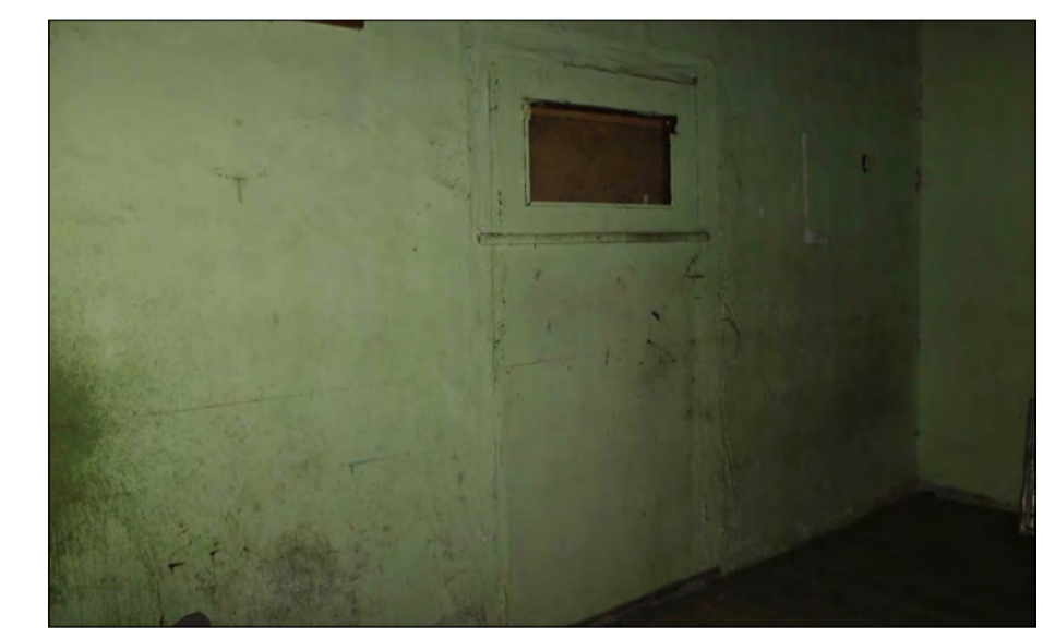
13 Habitación en planta alta, puerta añadida.
