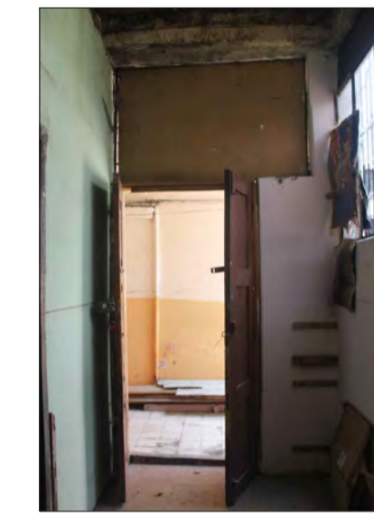
4) Planta baja paredes de bloque y puerta añadidas en torno a patio central.
