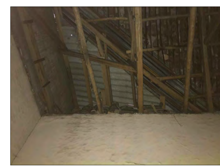
1 Planta alta, losa de hormigón y piso cerámico afiadido.
