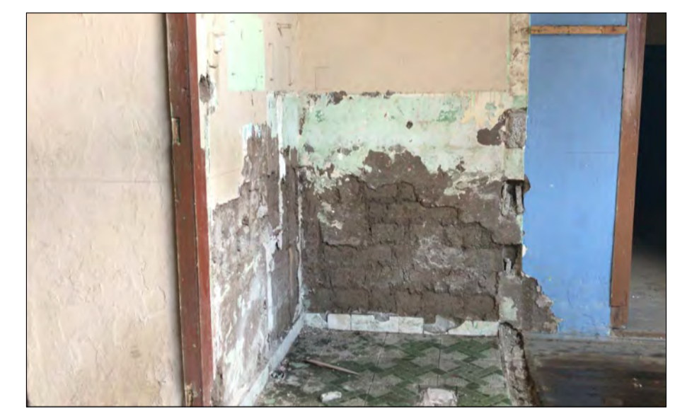
11 12 Planta alta, losa de hormigón y piso cerámico añadido en torno al patio central intervención de sustitución sobre la madera.
