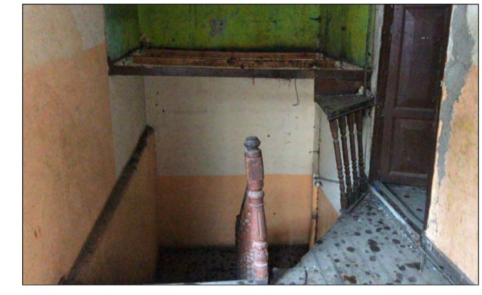
10 Acceso a habitación, corte en piso original
