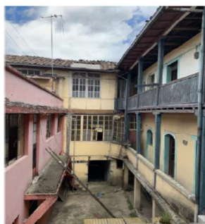
ESTADO ACTUAL-FACHADAS INTERIORES
