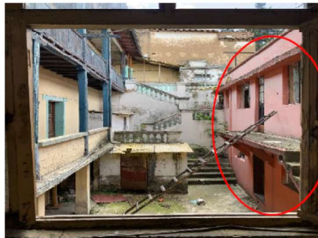
ESTADO ACTUAL-LIBERACIÓN DEL BLOQUE DE HORMIGON
