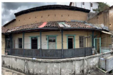
CUBIERTA DETERIORADA
