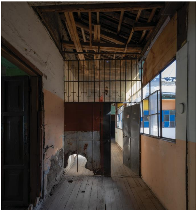
11- Divisiones ligeras posteriores a la añadidas. Material: metal.
