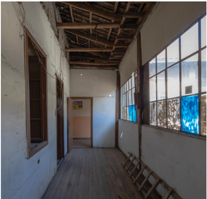
12- Divisiones en el pasillo añadidas. Material: ladrillo de bloque cementicio.
