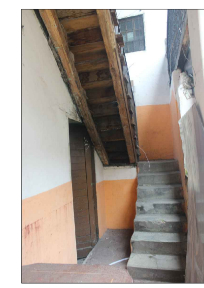
2) Patio posterior, escalera añadida.
