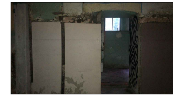
6) Planta baja, paredes de bloque añadidas delante de muro de adobes original.
