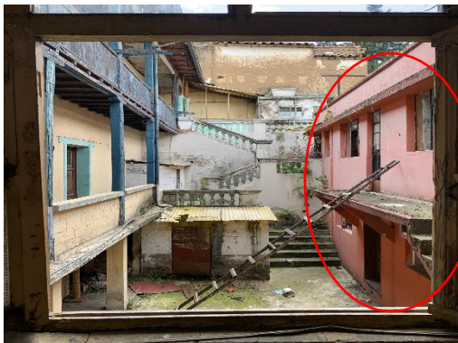
ESTADO ACTUAL-LIBERACIÓN DEL BLOQUE DE HORMIGON
