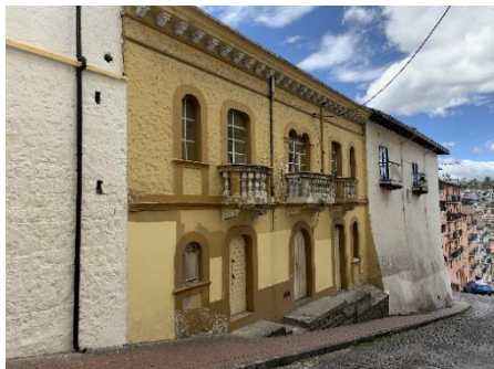
FACHADA FRONTAL-ESTADO ACTUAL
