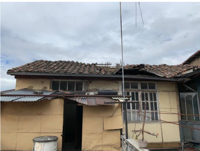
Imagen N°44. Condición cubierta • Fuente: Ilustración Propia
