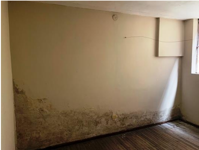
Imagen N°37. Eflorescencias dormitorios • Fuente: Ilustración Propia
