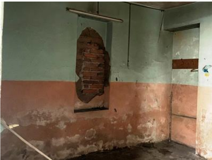
Imagen N°29. Local Comercial, desprendimiento de enlucido • Fuente: Ilustración Propia
