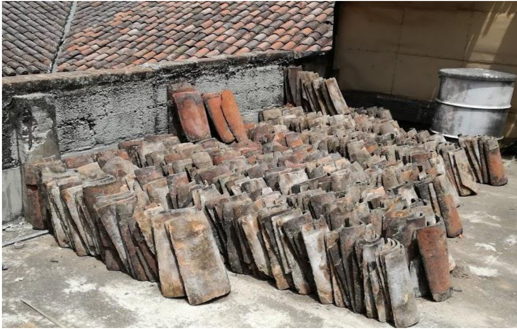
Fotografía N° 2 Recuperación Tejas Cubierta
