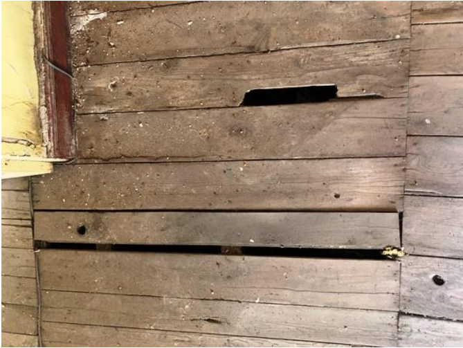
Imagen N°33. Pudrición de madera por agentes xilófagos • Fuente: Ilustración Propia
