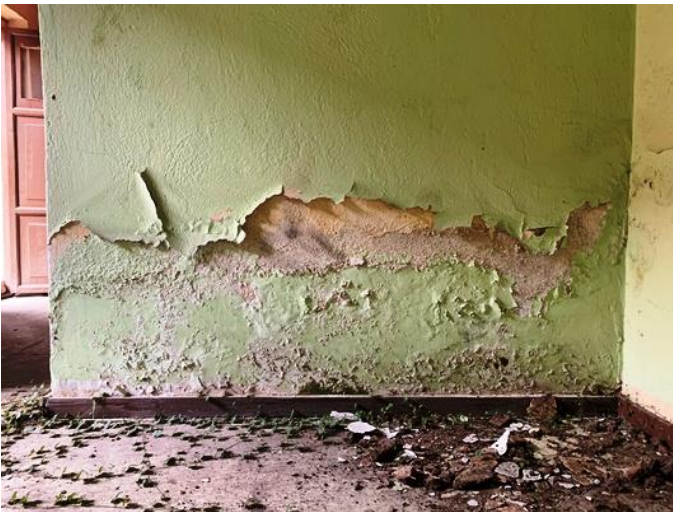
Imagen N°31. Líquenes, desprendimiento pintura • Fuente: Ilustración Propia
