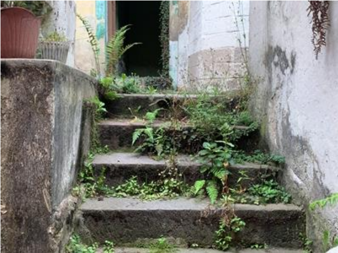
Imagen N°30. Gradas con vegetación • Fuente: Ilustración Propia
