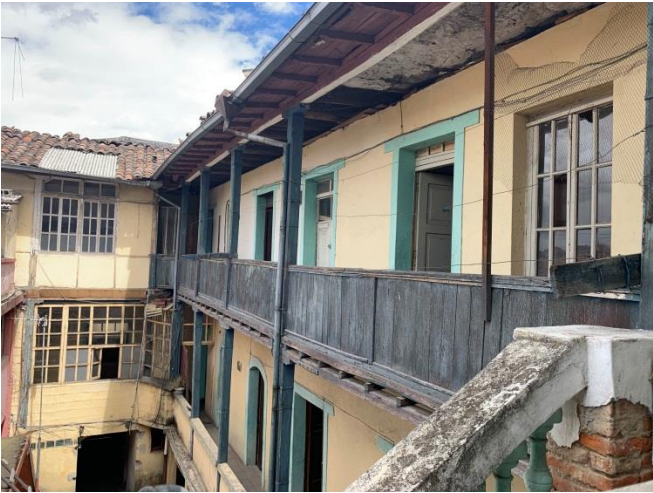
Imagen N°43. Condición de alero, galería • Fuente: Ilustración Propia
