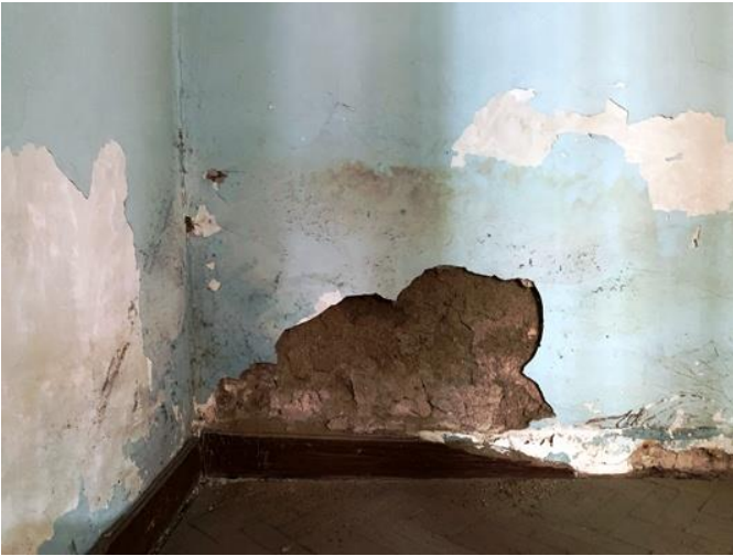
Imagen N°34. Desprendimiento de adobe • Fuente: Ilustración Propia
