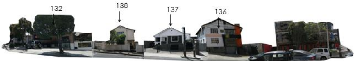
Tramo 7: Calle Toledo entre Francisco Salazar y Cordero
