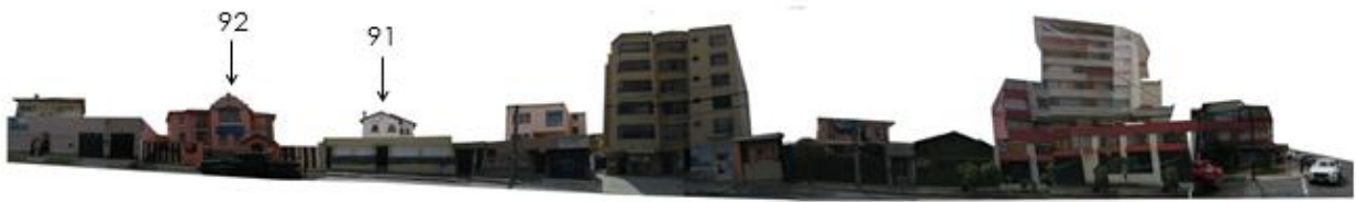
Tramo 6: Calle Toledo entre Madrid y Galavis
