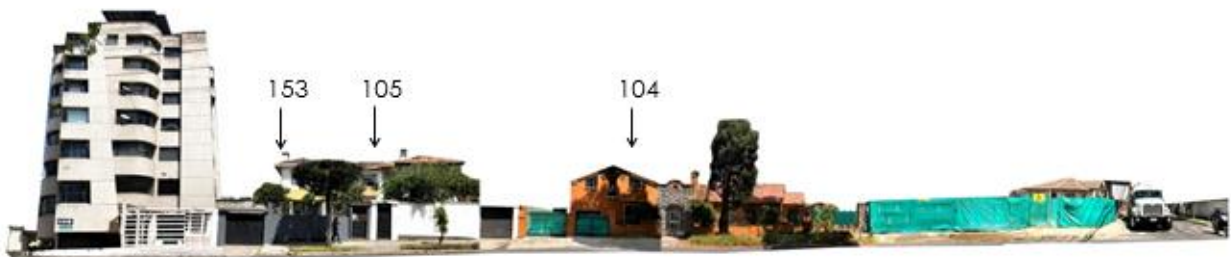
Tramo 8: Calle Toledo entre Francisco Salazar y Cordero
