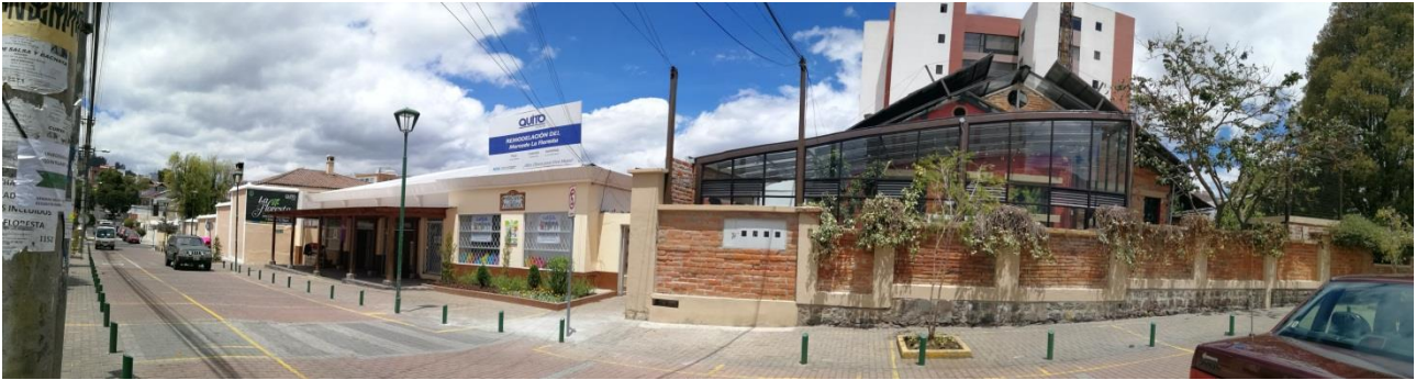
Fotografía N° 3 Vista General de la calle Galavis Fuente: IMP
