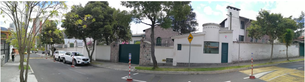
Fotografía N° 8 Vista general de la calle Francisco Salazar Fuente: IMP
