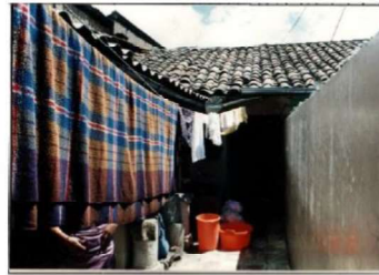
FOTOGAFIA DEL INTERIOR DEL INMUEBLE (FICHA DE INVENTARIO)
