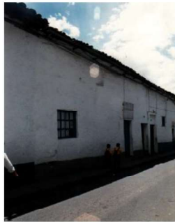
FACHADA-FOTOGRAFIA TOMADA DE LA FICHA DE INVENTARIO
