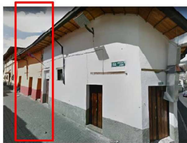
INMUEBLE INVENTARIADO FACHADA (foto 1) ANTES DE SER DERROCADO
