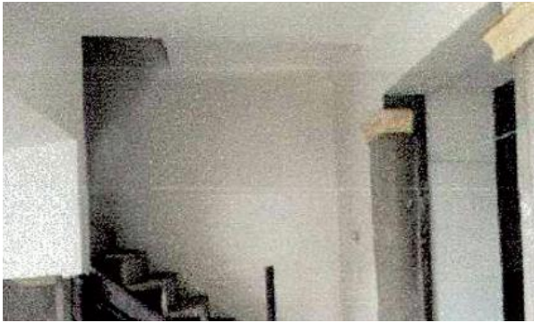
Tumbados del hall recubiertos de gypsum
