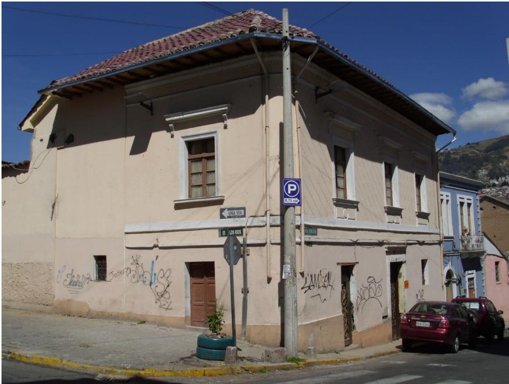
VISTA PRINCIPAL CALLE BRICEÑO Y CALLE RÍOS
