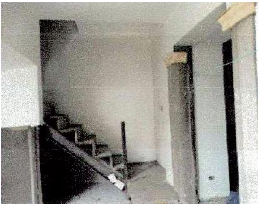
Gradas que comunican a la planta del segundo piso
