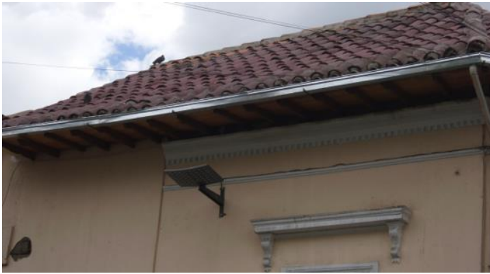
Cubierta hacia la calle Los Rios
