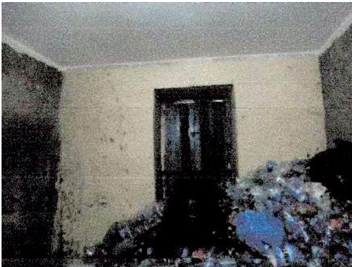
Interior local, puerta hacia la calle Los Ríos, tumbado recubierto de gypsum
