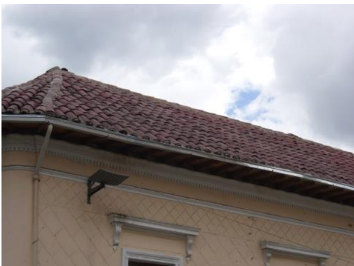
Cubierta calle Briceño
