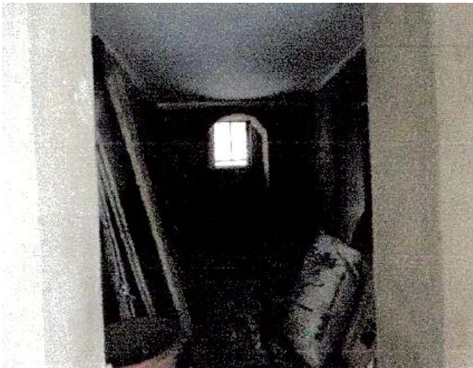
Interior cuarto 2, paredes sin estucar, techos recubiertos con gypsum
