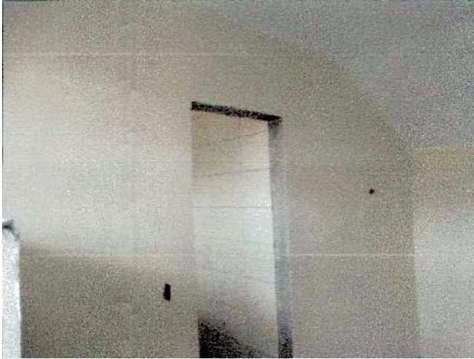
Interior de bodegas
