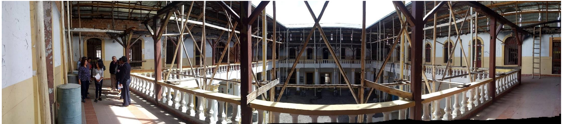
CORREDOR PLANTA ALTA OESTE
