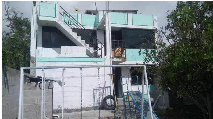
Fachada frontal bloque 3
