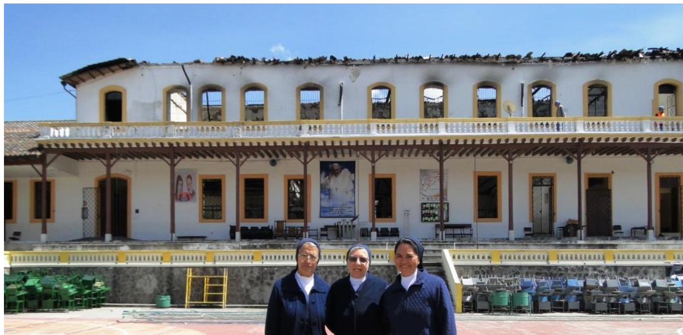
FOTO: DESPUÉS DEL INCENDIO
