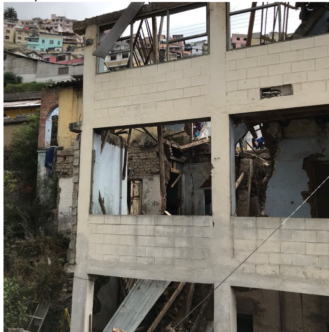
FOTOGRAFIA N 5: CONSTRUCCION MIXTA HORMIGON ARMADO MAMPOSTERIA DE BLOQUE
