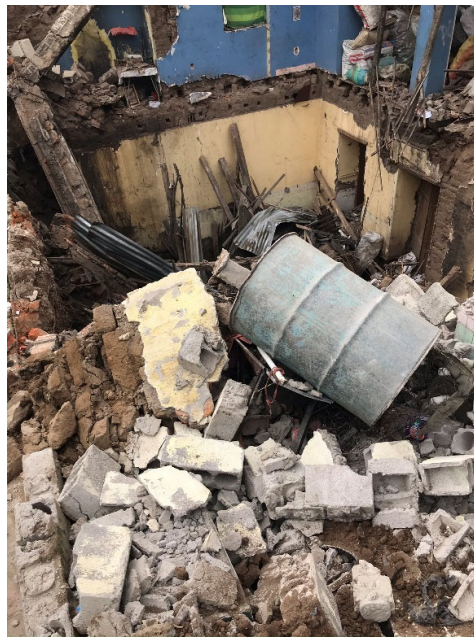
FOTOGRAFIA N 12: APUNTALAR ELEMENTOS SUELTOS Y DERROCAR CONSTRUCCION COLAPSADA EN RUINA
