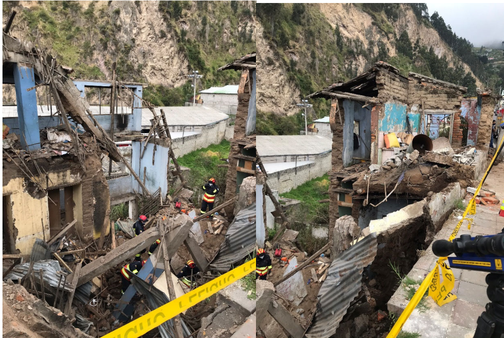
FOTOGRAFIA N 3-4: CONSTRUCCION MIXTA ADOBE MADERA – HORMIGON ARMADO
