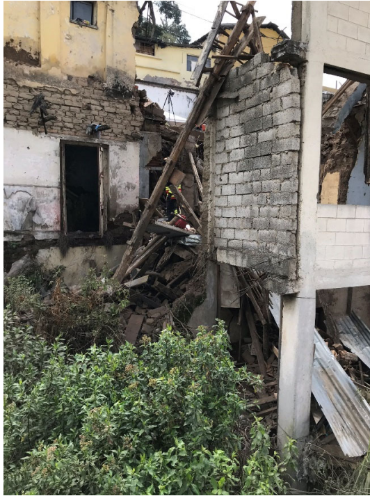
FOTOGRAFIA N 6: CONSTRUCCION MIXTA ADOBE MADERA – HORMIGON ARMADO
