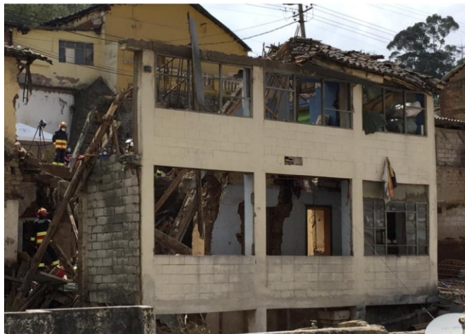
Fotografía del inmueble 28 mayo 2020
