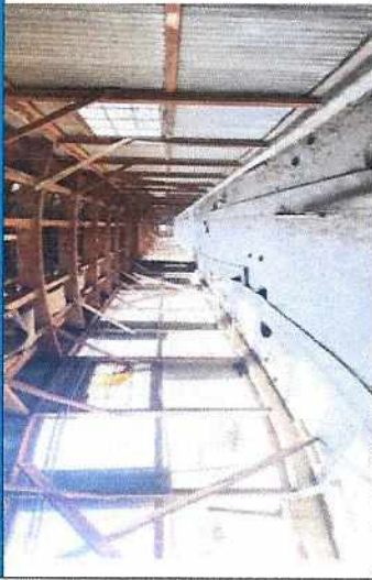
Descripción: Vista interior de estructura de la cubierta de los silos
