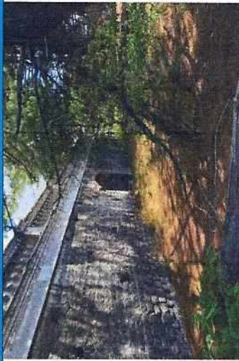
Descripción: Detalle de muro de piedra y balaustrada.
