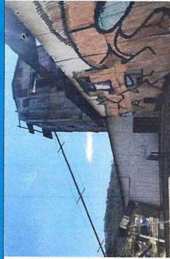
Descripción: Vista general de remate de fachada de silos. La estructura de la cubierta esta desarrollada en madera y su recubrimiento tanto en mampostería como de cubierta es de asbesto cemento.
