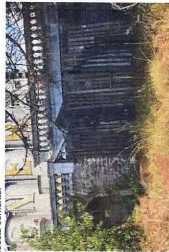
Descripción: Vista general de remate de fachada de silos. La estructura de la cubierta esta desarrollada en madera y su recubrimiento tanto en mampostería como de cubierta es de asbesto cemento.
