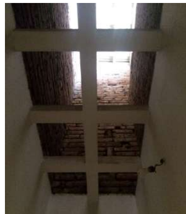
Imagen 6. Pozo de luz, hall entre cocina y comedor PB Fuente: DCSBPC- 18 junio 2019
