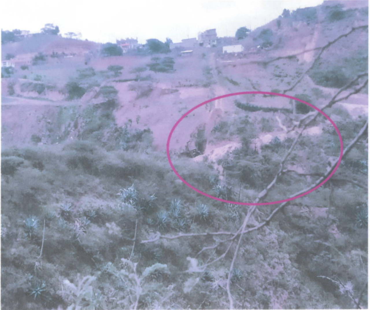
Fotografía 1. | Ingreso de maquinaria a la quebrada Humayaku (Jalonguilla) 16 de mayo del 2022 Fuente: Gonzalo Guañuna
