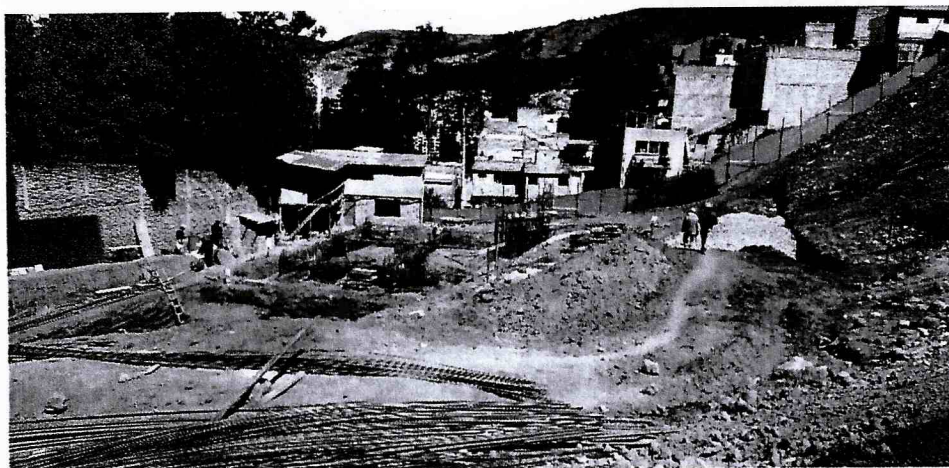
Fotografía 1: Actividades de construcción en el predio que colinda con el "Mirador".
