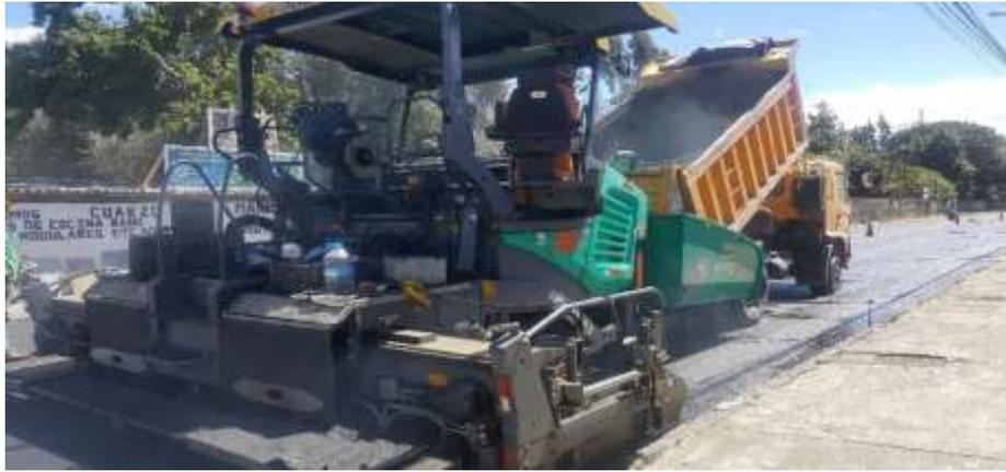
Se controla la compactación de la mezcla teniendo cuidado con los drenajes de la vía para que no queden charcos producto de las lluvias una vez terminado el trabajo, así como el paso del rodillo de adentro para afuera como muestra la imagen.
