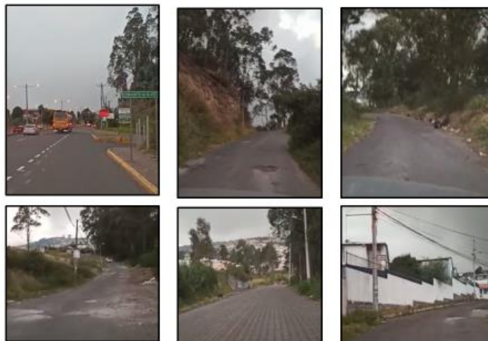
SITUACIÓN ACTUAL DE LA CALLE S6C
