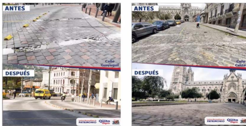
Intervención integral en calzadas de piedra
