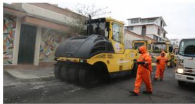
Contrato de repavimentación de las calles de Quito. Fuente: Primicias
