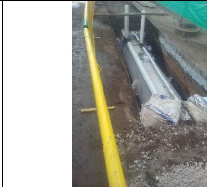
Fig. 3. Tramo excavado durante la noche.
