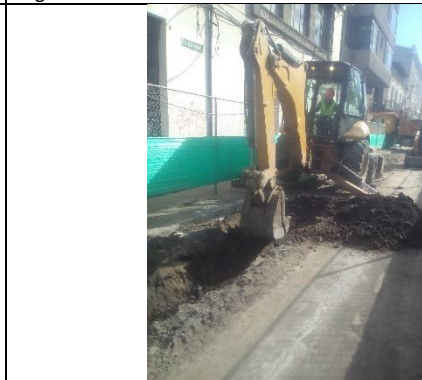
Fig. 5. Excavación en Av. Gran Colombia y Ascencio Gándara.
